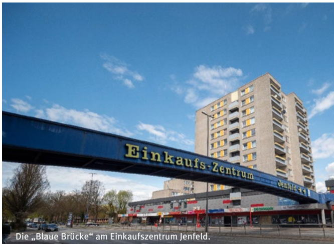
Die „Blaue Brücke“ am Einkaufszentrum Jenfeld.
