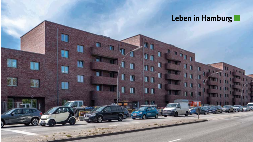
Mietshäuser am Sportplatzring/Ecke Basselweg: „Der skulpturale Ansatz des Neubaus sorgt für die besondere Wohnqualität der 123 Ein- bis Vier-Zimmer-Wohnungen“, wirbt der Vermieter.
